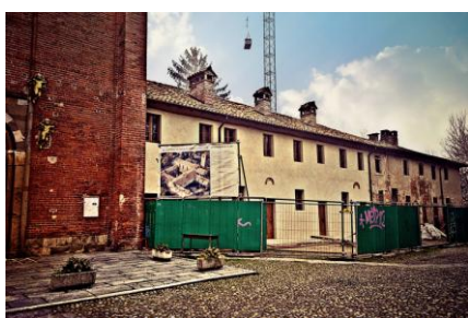
Chiostro Piccolo lato ovest: com'era
